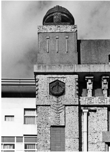
図3 旧・宇都宮商工会議所 南西角上部 屋上の装飾 設計=安 美賀 | 竣工 1928年 撮影=1970年代末、藤原宏史
