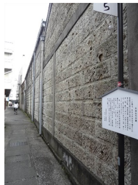
図 5 あさり川小道の材木倉庫
