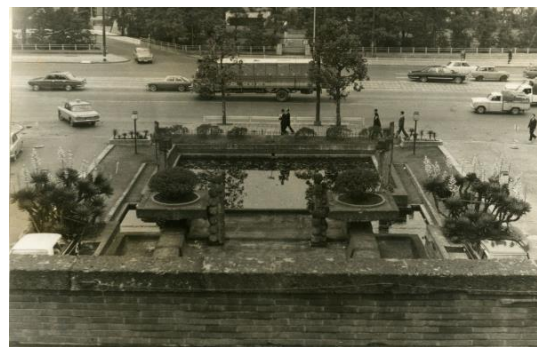
屋上より池・日比谷通りを望む
