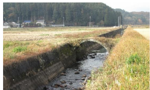
篠井町逆川に架かる石橋
