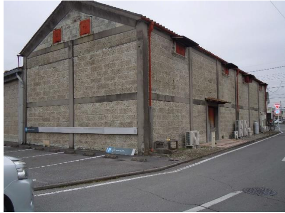
写真 4 コンクリート枠に支えられた石蔵。昭和 28 年建築。宇都宮市吉野町。当初米の貯蔵庫として建築。
