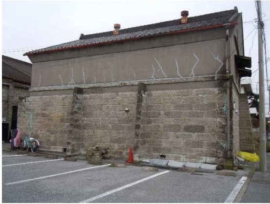
写真 3 バットレスのある石蔵。昭和 14 年建築。那須烏山市。那須通運石造り倉庫群の一つ。
