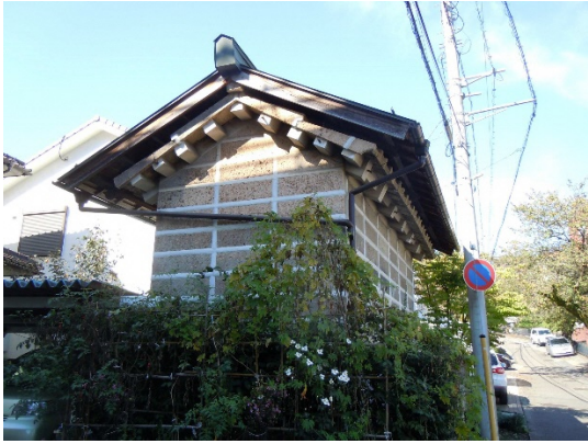
写真 1 石屋根を覆った屋根
