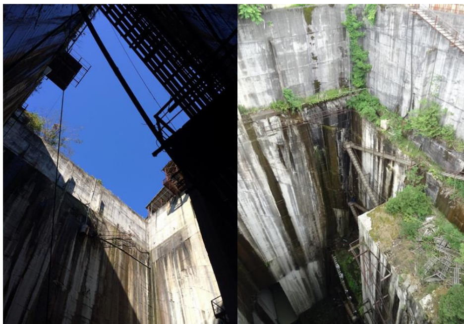
写真3 立坑（左：見上げ風景、右：見下ろし風景）
