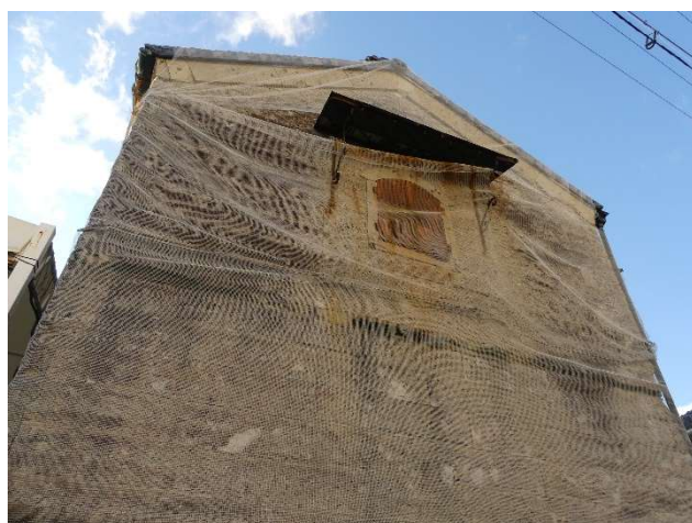
▲ 浜松市街地の石蔵（表面剥落のため網がかけてある）
